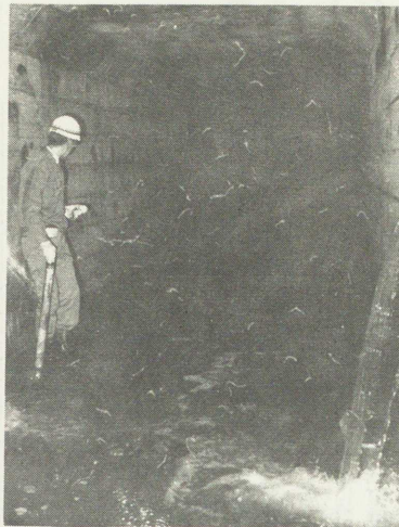
完成した公共下水道管の内部
